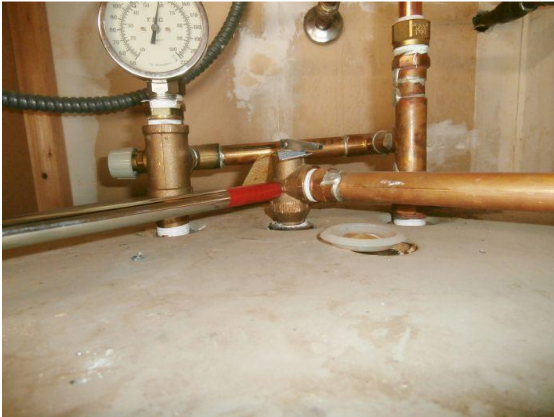
Water Heater / T.P.R.V.
